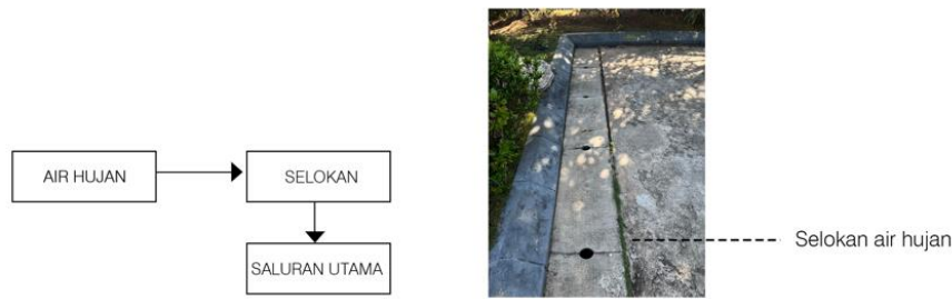
Gambar 8. Pembuangan Sistem Air Hujan pada Resor B
