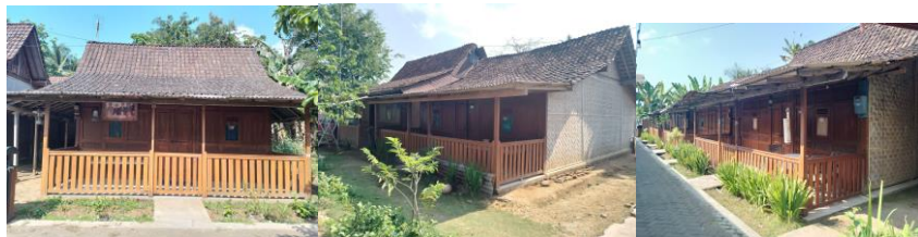
Gambar 4. Material Rumah Osing dan Ruang luar pada rumah Osing Sumber : Dokumentasi Penulis
